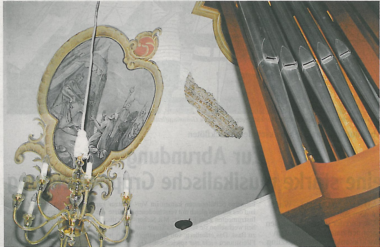
Zwischen Deckengemälde und Orgelpfeifen ist das rund 170 mal 40 Zentimeter grosse Loch in der Decke zu sehen.
