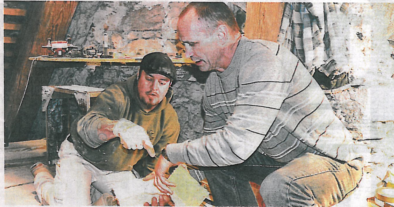
Werner Debon (rechts) schaut sich mit einem Mitarbeiter ein Stück des entfernten Isolierschaums an.
