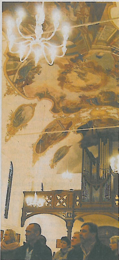
Die Decke in der Kirche St. Katharina hält wieder.
